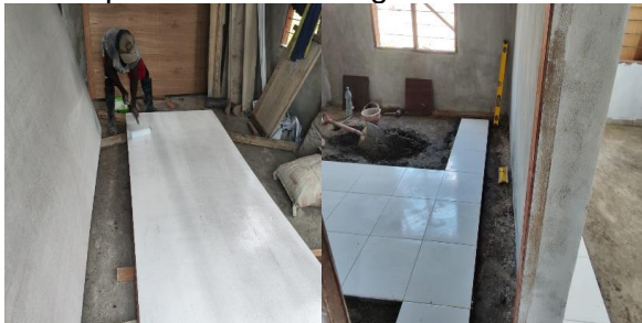
Gambar 4. Pekerjaan Plafond dan Lantai
