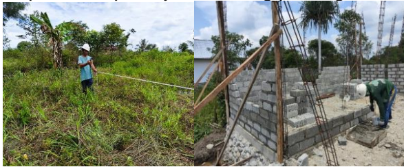
Gambar 2. Kegiatan pekerjaan tanah dan beton
